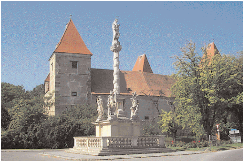
Vier hohe Ecktürme überragen das ehemalige Wasserschloss Orth
