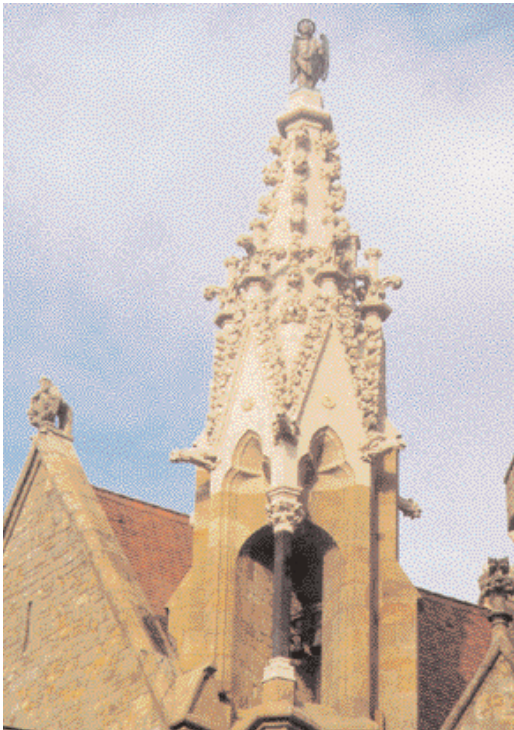
Kreuzenstein, Burg, Kapellenturm nach Restaurierung
