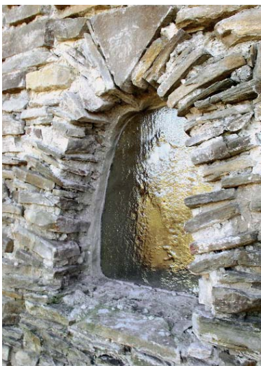
Fenster aus der großmährischen Etappe. (Foto: V. Ferus)
