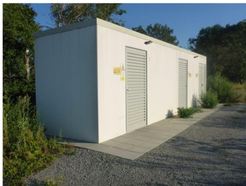
Bild 3: Schaltstation, Ansicht von N (Detail)
