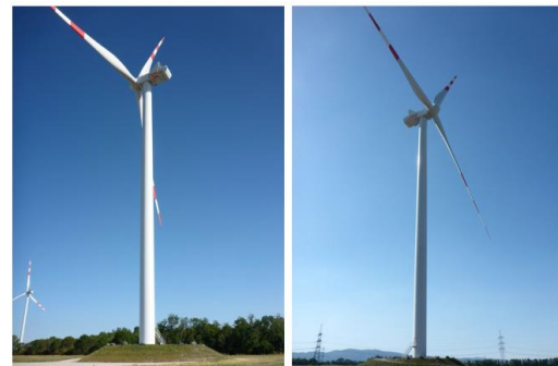
Bild 2: Turm und Rotorblätter WKA TM 1 (links - Blickrichtung SO, rechts - Blickrichtung NW)
