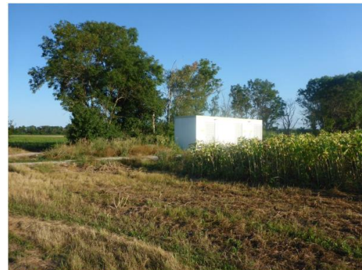
Bild 2: Schaltstation, Ansicht von N
