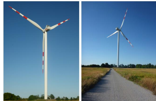
Bild 14: Turm und Rotorblätter WKA TM 7 (links - Blickrichtung O, rechts - Blickrichtung N)
