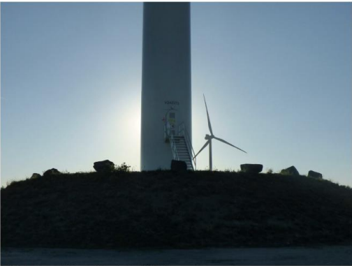
Bild 5: Fundamentfläche und Turmbasis WKA TM 3
