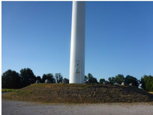
Bild 13: Fundamentfläche und Turmbasis WKA TM 7
