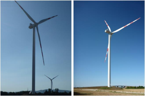
Bild 8: Turm und Rotorblätter WKA TM 4 (links - Blickrichtung NW, rechts - Blickrichtung NNO)
