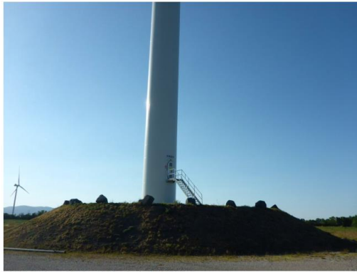
Bild 11: Fundamentfläche und Turmbasis WKA TM 6
