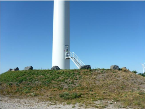
Bild 7: Fundamentfläche und Turmbasis WKA TM 4
