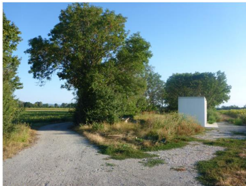
Bild 1: Schaltstation, Ansicht von NO
