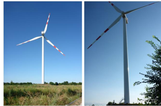
Bild 12: Turm und Rotorblätter WKA TM 6 (links - Blickrichtung NO, rechts - Blickrichtung SW)
