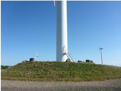
Bild 3: Fundamentfläche und Turmbasis WKA TM 2
