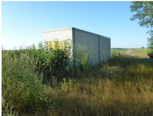
Bild 5: Schaltstation, Ansicht von S
