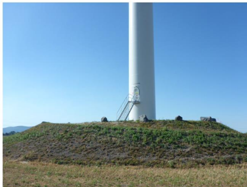
Bild 1: Fundamentfläche und Turmbasis WKA TM 1
