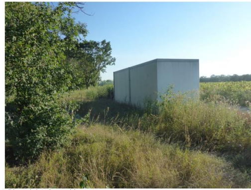
Bild 6: Schaltstation, Ansicht von O
