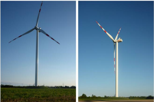
Bild 6: Turm und Rotorblätter WKA TM 3 (links - Blickrichtung SW, rechts - Blickrichtung SO)
